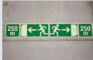
Piktogramme und Richtungspfeile weisen zum nächstgelegenen sicheren Bereich, die maximale Entfernung dorthin beträgt 250 Meter.
