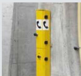
Notrufsäulen an den Tunnelportalen und den Rettungsschleusen im Tunnel gewährleisten die Kommunikation zwischen Fahrgästen und Rettungskräften.
