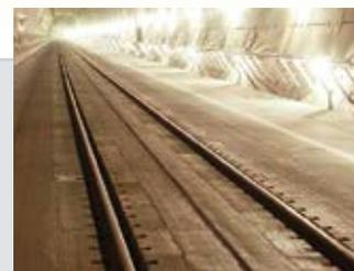
Die „Feste Fahrbahn“ in beiden Röhren kann mit normalen Straßenfahrzeugen befahren werden, die Rettungskräfte gelangen somit schnell an ihren Einsatzort.
