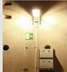
Die Fluchtwege werden bis in den Bereich der Tröge an den Tunnelportalen durchgehend beleuchtet.
