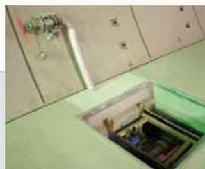
Alle 125 Meter sind Löschwasserentnahmestellen im Tunnel angebracht. Sie können über zwei Stunden hinweg mit 800 Litern Wasser pro Minute versorgt werden.
