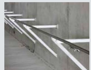
Als zusätzliche Hilfe werden auf einer Höhe von etwa einem Meter Handläufe an den Fluchtwegen angebracht.
