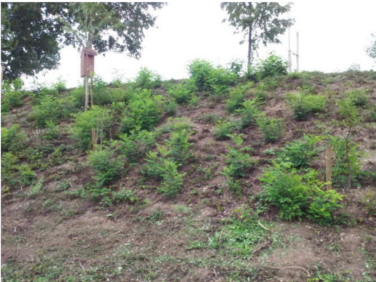
Bild 4: Neckardamm bei Mannheim-Feudenheim, Maulbeerinsel Robinienwurzelaustriebe nach Fällungen mit Herausnahme des Wurzelstockes
