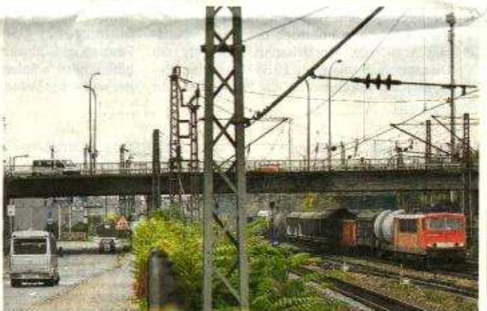
Zuglärm nervt die Anwohner am Bahnhof Waldhof genauso wie Mannheimer an 13 weiteren Stellen an den Bahnstrecken im Stadtgebiet.
